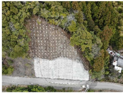
2. 高知県南国市中谷 市道中谷上倉線法面工事
