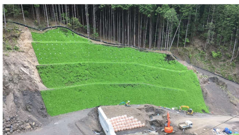
緑化後 施工後三ヶ月
