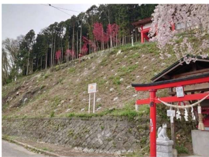
4. 岩手県盛岡市山岸 山岸一丁目急傾斜地崩壊対策工事
