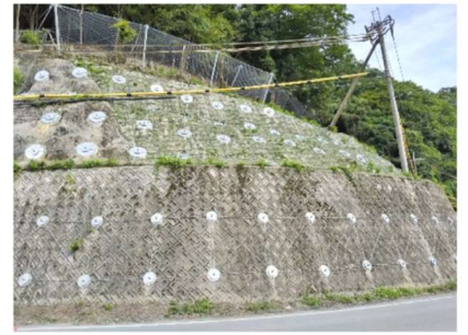
3. 大阪府道・京都府道 46 号 茨木亀岡線道路防災工事
