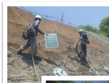
8.緑化基盤材の施工
