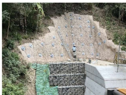
8. 和歌山市西庄 猿坂谷砂防堰堤袖部斜面補強工事
