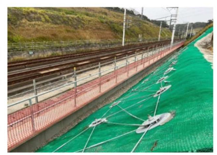
9. 台湾苗栗(国外) 台湾新幹線 TK126 災害復旧工事
