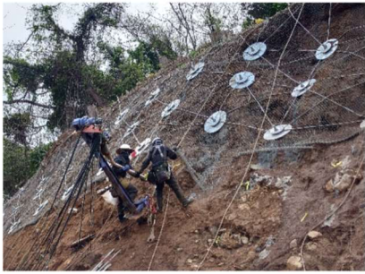
1. 長崎県松浦市(SD 工法削孔) 一般県道星鹿港線改良工事
