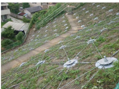
7. 大阪府枚方市御殿山町 御殿山地区急傾斜地法枠補修工事
