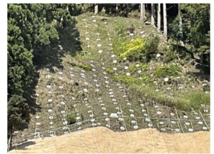
6. 滋賀県高島市朽木荒川 高島市朽木荒川地区復旧治山工事
