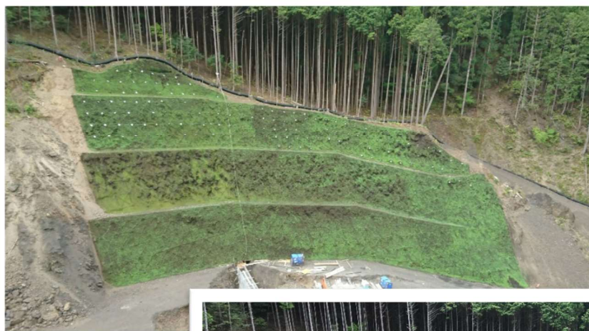
緑化後 施工後一ヶ月
