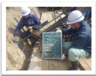
3.ロックボルトの打設工
