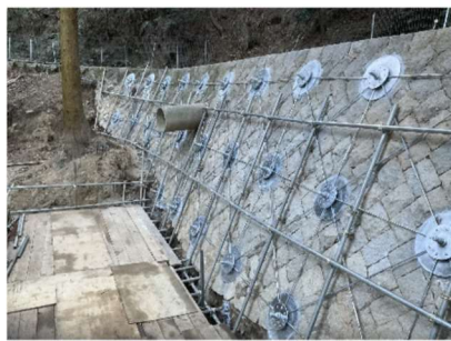
5. 愛知県蒲郡市神ノ郷町桃山 林道白龍線災害復旧工事
